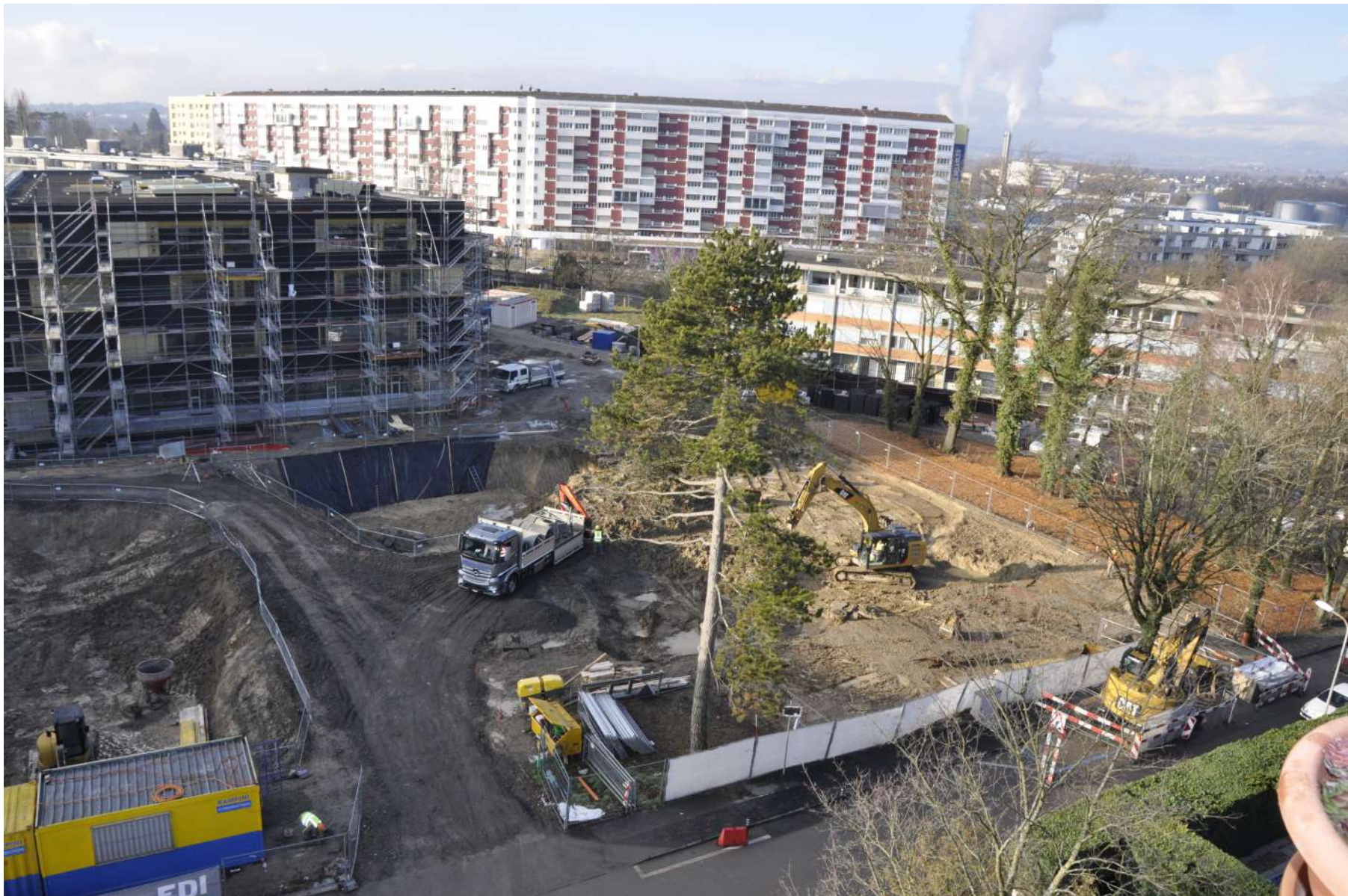
Nouvelle école Emilie de Morsier, et construction de logement, rue Jean-Simonet
