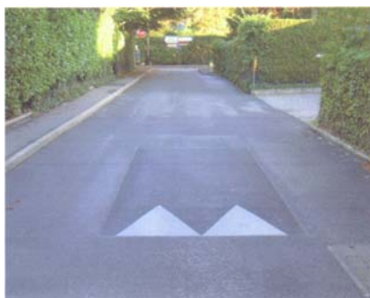
Modération de la vitesse des véhicules par la mise en place de « coussin berlinois »
