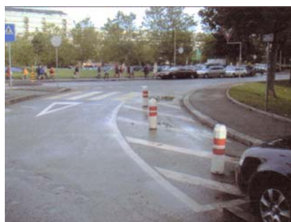
Rétrécissement de la largeur des traversées piétonnes par la construction d'une avancée de trottoir réalisée avec du marquage et des potelets.
