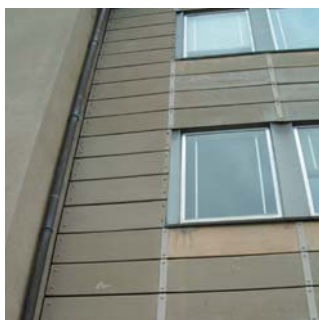
Détail d'une des façades en bardage de panneaux préfabriqués en ciment (SMS).
