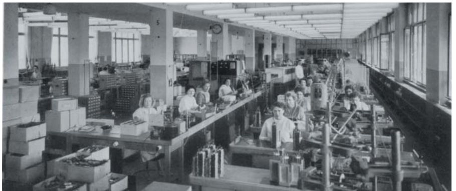
Tavaró, bâtiment de montage, premier étage, préassemblage, vers 1955. Une main d'oeuvre essentiellement féminine, faiblement qualifiée, pour un travail peu valorisant.
