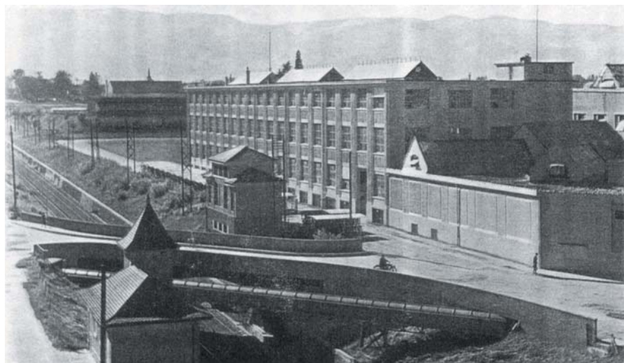
Tavano, bâtiment Pic-Pic, montage des détonateurs, 1942. Après l'avoir totalement investi en 1937, l'entreprise rachète l'immeuble en 1940.
