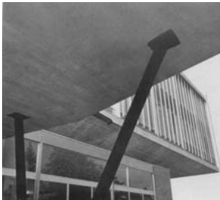
Détail de la marquise proéminente en béton, 1958 (Bauen+Wohnen).
