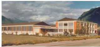
L'usine de Sion, spécialisée dans les moteurs électriques.
