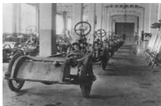
Piccard, Pictet & Cie, bâtiment de montage, 1920. Assemblage de la première série de 500 châssis. Le plan allongé et la structure ponctuelle permettent la mise en place de trois lignes de production (CIG et, en haut, AEG).
