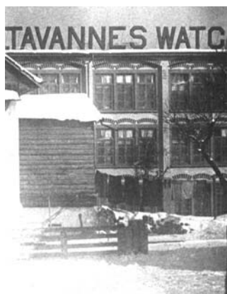
Bâtiment historique de Tavannes Watch SA & Co, construit à Tavannes au début du XXème siècle (API).
