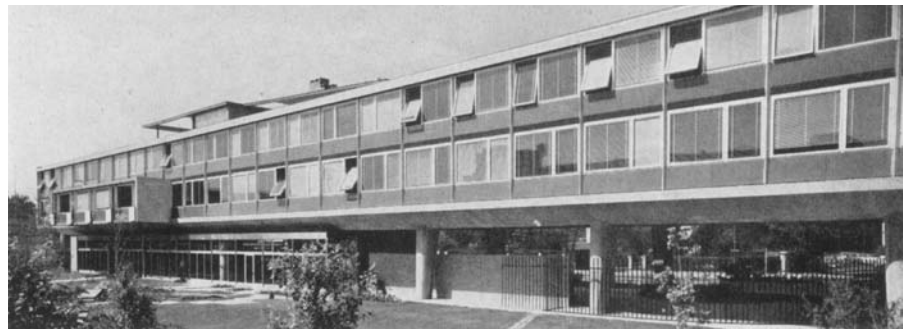
La façade arrière est rythmée par la trame modulaire des panneaux verre / aluminium (Bauen+Wohnen).
