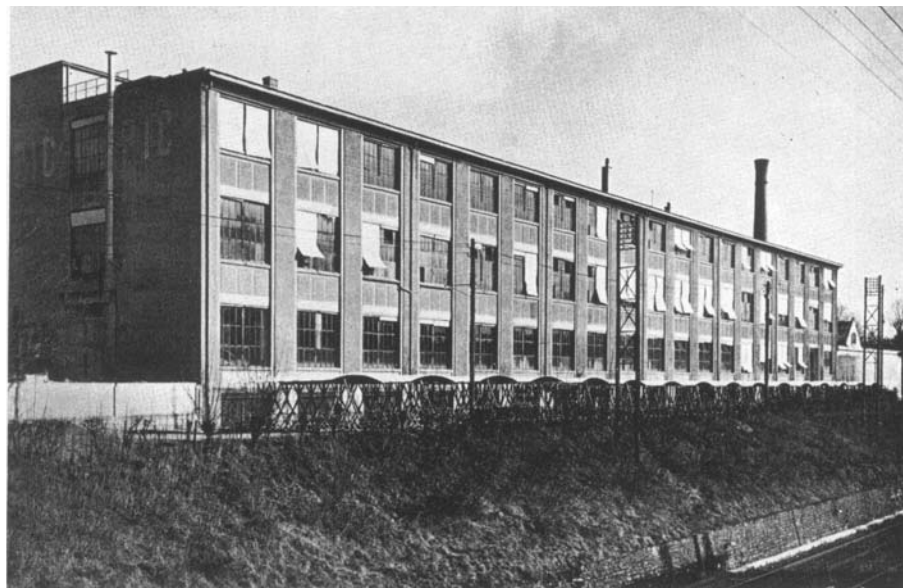
Ateliers des Charmilles, ancien bâtiment de montage, 1937. Les surfaces sont louées à différentes sociétés à caractère plus ou moins industriel (Olivet).
