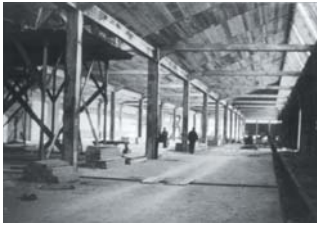
Trois étapes de la construction des ateliers à sheds, réalisés en béton plutôt qu'en acier, matériau traditionnellement utilisé pour ce type de structure.
