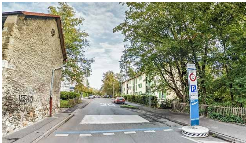
L'avenue Henri-Golay il y a cinq ans, avant le réaménagement: cette rue marque la limite communale entre Vernier et Genève. La vitesse y a été abaissée à 30 km/h.
