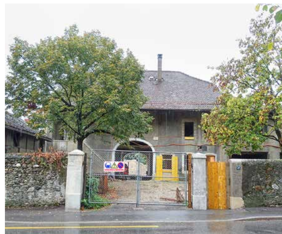
La ferme Menut-Pellet est en chantier. Elle abritera bientôt la maison de quartier.
