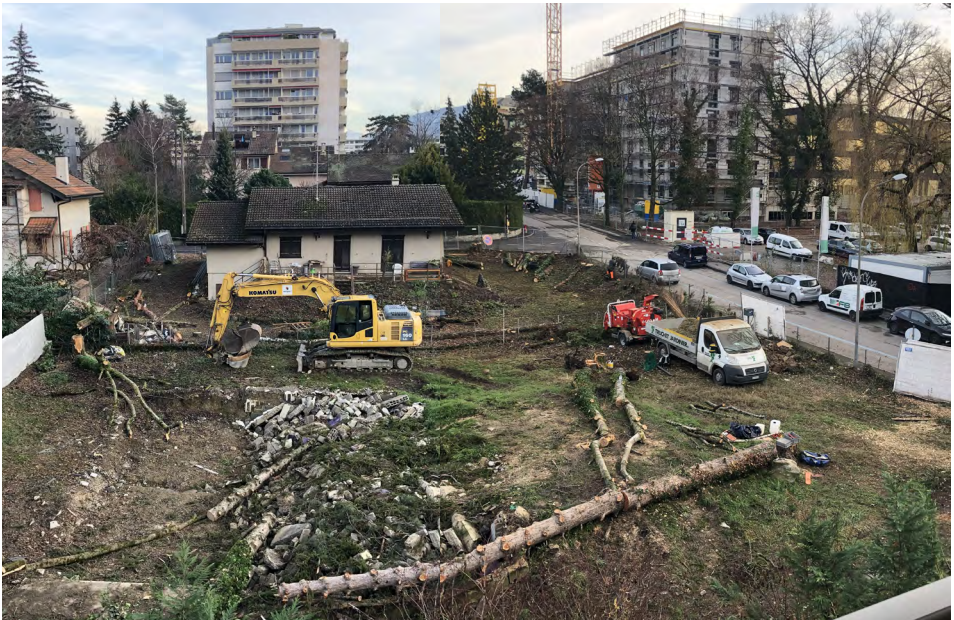
Début du chantier du secteur C à l'angle de la rue Jean-Simonet et chemin Croissant. Défrichement de toute la végétation. Photo @habitant Concorde
