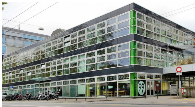
Le 99-Espace de quartier
